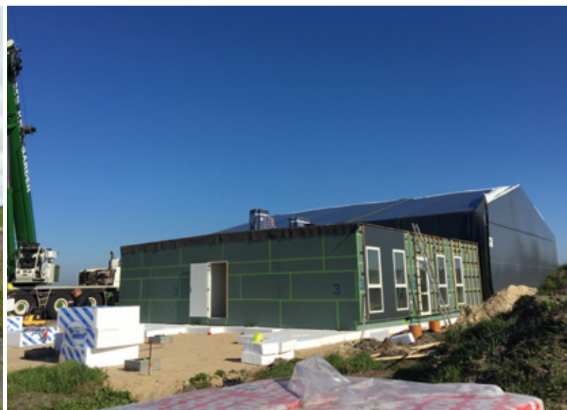
Basebyggeriet i Aalborg 18. september 2018
