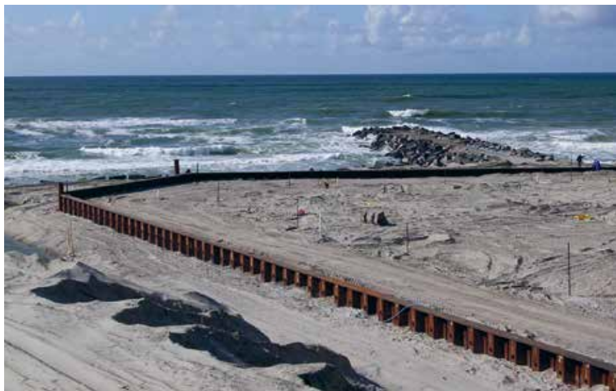
August 2006, depotet ved Højde 42 bliver indkapslet med en jernspuns.
