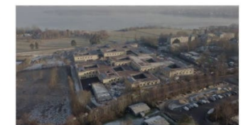
'Udsigten' er snart bygget færdig Se dronefilm fra byggeriet
