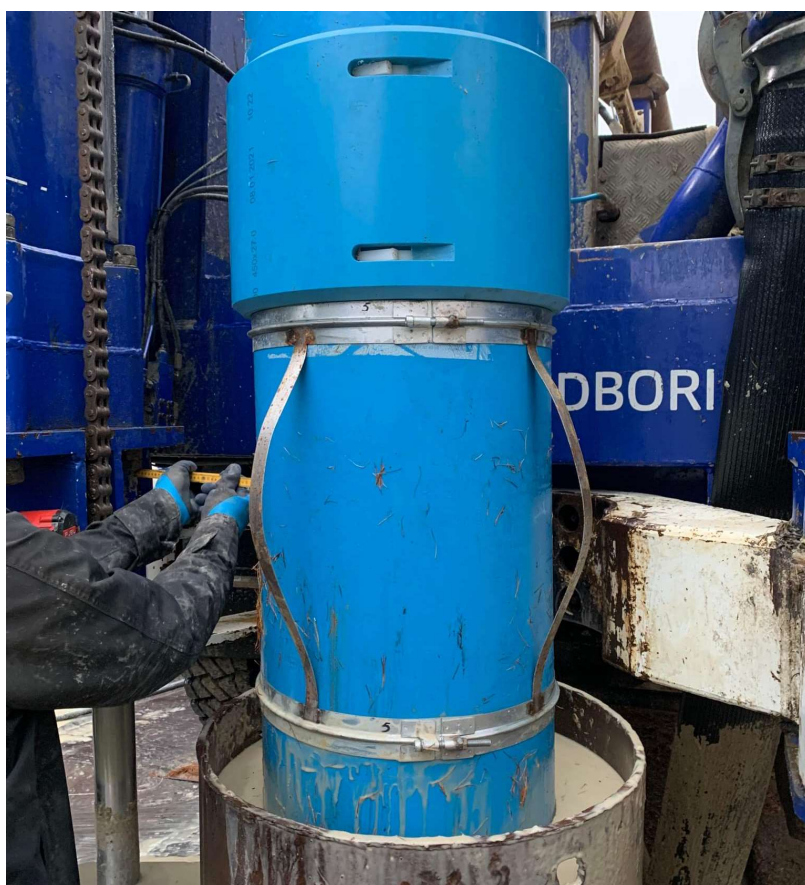
Figur 7-5 Robust, rustfrit styr til store dimensioner og åbnekalkboringer. (Kilde: Jesper Furdal, Awell).
