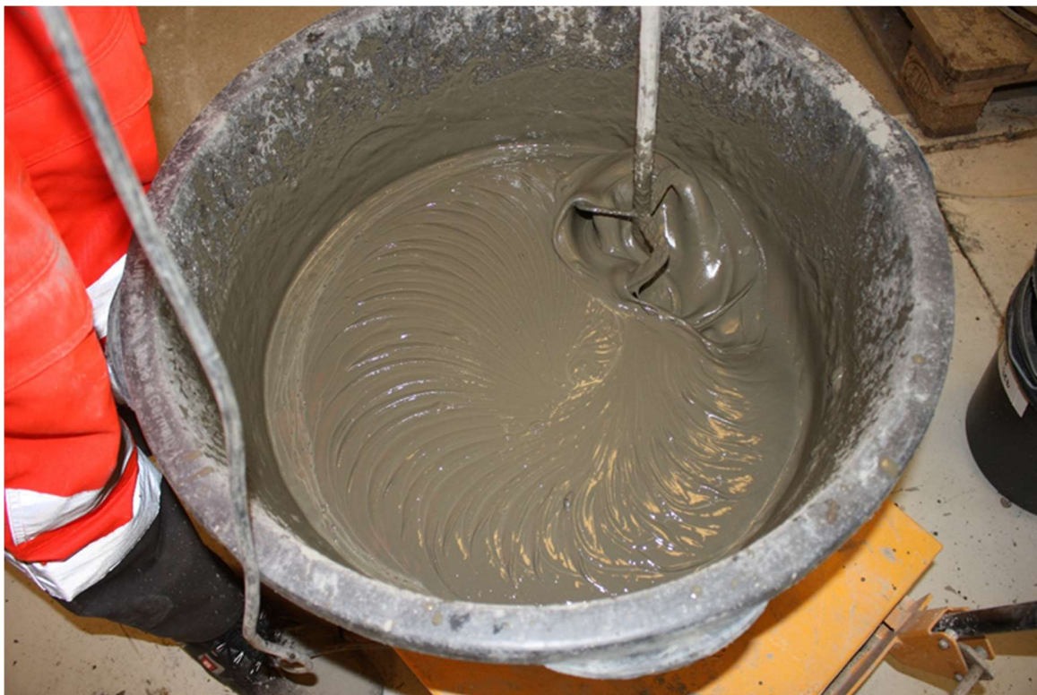
Figur 8-2 Konsistensen af grout skal være som "ymer"
