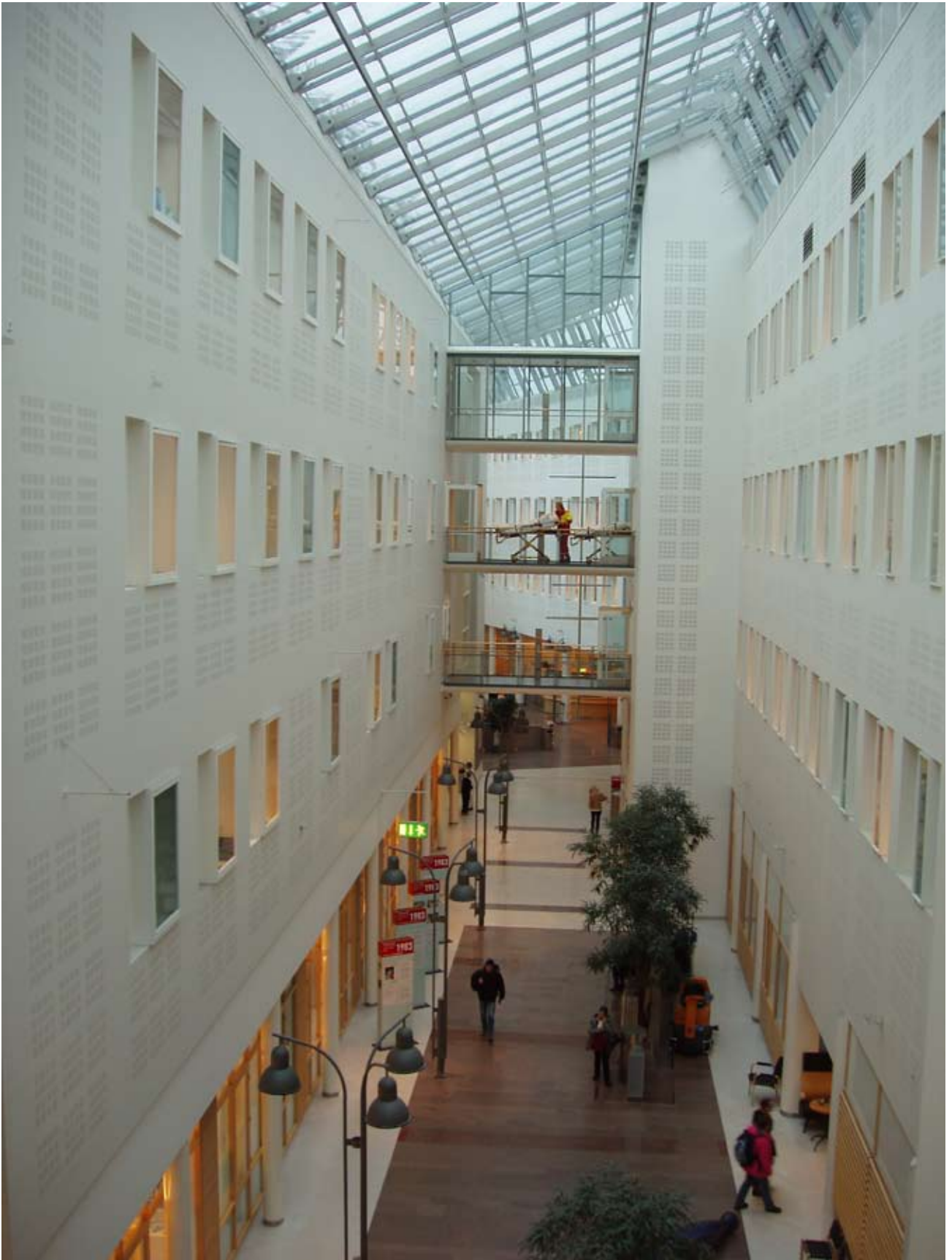
Akustisk regulering integreret i facadebeklædningen, Rikshospitalet Oslo
