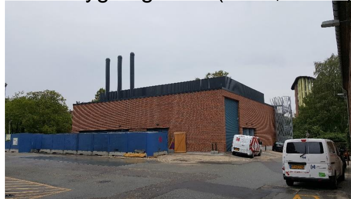
Teknikbygning BBH (GEN, ATES)
