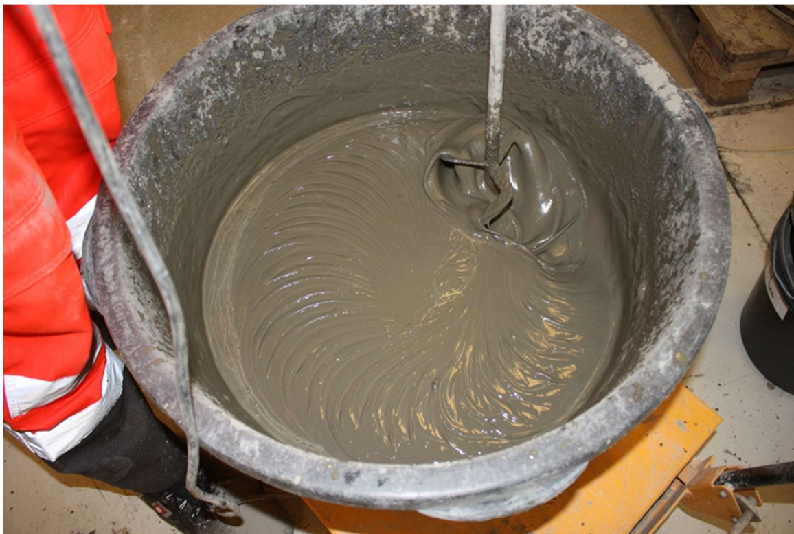
Figur 8-1 Konsistensen af grout skal være som "ymer"
